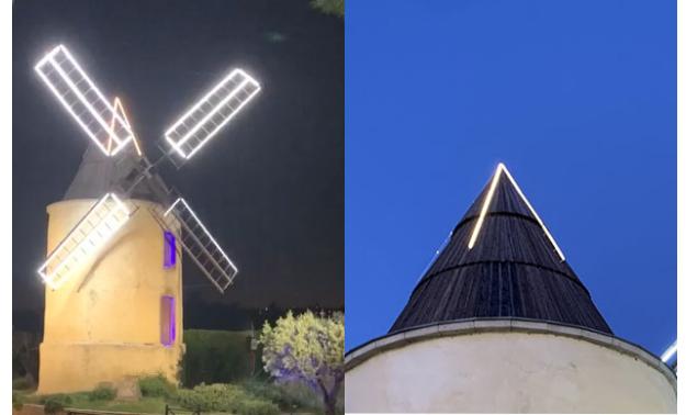
Surlignage de la toiture du moulin à l'aide de barreaux Lignon ref 5655
