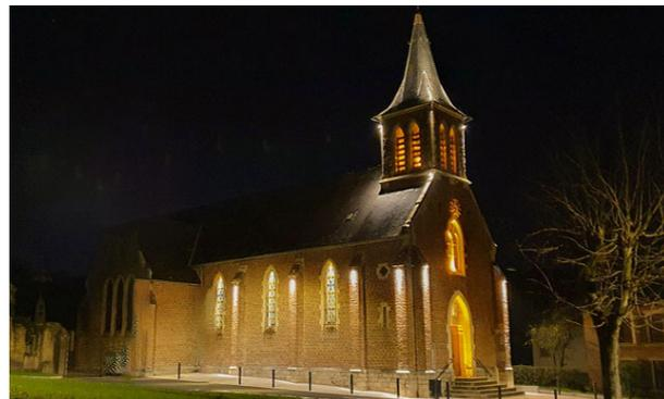
Des projecteurs **Luminy2 (4020)** sont installés sur le haut des arrêtes de la toiture, des arrêtes extérieures du clocher et de la façade principale afin de mettre en valeur le bâtiment. Le faisceau frise le pilastre et dessine une ligne.
